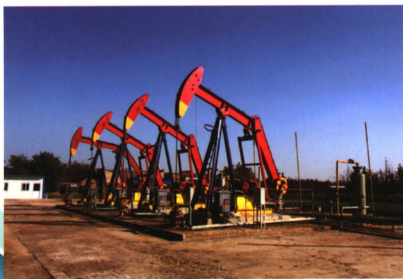
煤层气抽采井
