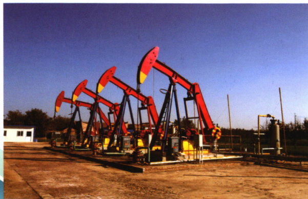
煤层气抽采井
