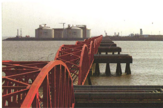
LNG接收站期待松绑
