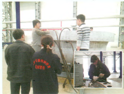
清华大学核能与新能源研究院 法兰和上盖法兰对应密封面修复
