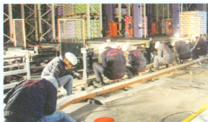
内蒙古伊利实业集团 立体库输送轨道磨损修复
