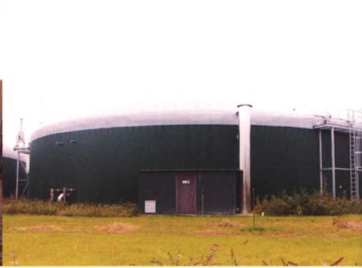
该厌氧发酵罐工艺罐体采用钢筋混凝土预制板拼装结构,可以实现高质量、高精度、低成本,具有施工性,适用于各种规模的项目,而且可以缩短现场施工周期。进料由螺旋输送机和物料泵送至搅拌罐,罐中心安带锯齿转盘的搅拌器,用来进行物料混合。设备采用密封结构,常压状态运行。搅拌时间、进料间隔时间、日进料都均可输入计算机控制系统,并根据运行要求来调整。发酵罐产生的沼气从双膜储气柜送至提纯系统。
