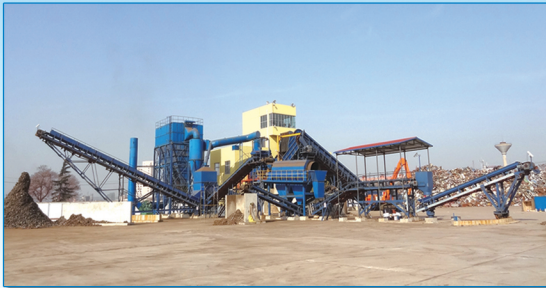
PSX-3000马力废钢破碎生产线在河南灵宝工作现场
