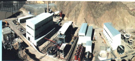
青海滩间山金矿EPCM项目
