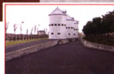
上海奉贤奉城新镇钢渣透水混凝土道路
