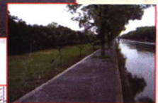
宝钢厂区人行道钢渣透水混凝土景观路面
