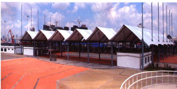
世博园区钢渣透水混凝土（砖）景观路面
