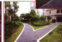
水木年华生活社区钢渣透水混凝土景观路面
