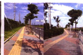
世博园区钢渣透水混凝土（砖）景观路面
