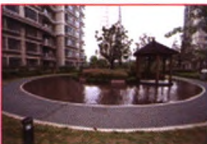
水木年华生活社区钢渣透水混凝土景观路面
