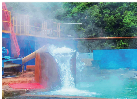
成功勘探丽水水平桥东源地热温泉，观察期井口水温达58度，水量、水温、水质均达到优质温泉的标准。
