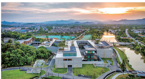
受浙江省委宣传部的委托，高质量完成了中国国家版本馆杭州分馆的岩土工程勘察、地质灾害防治、基坑第三方监测等任务。
