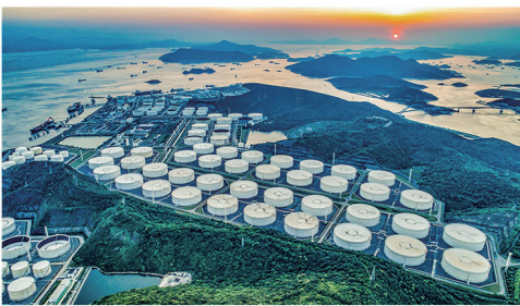
利用物探勘察新技术为黄泽山油品储运贸易基地选址提供决策依据，依托该项目成功经验，主编《地下水封洞库工程物探规程》（SY/T486-2020）
