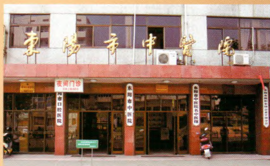
老院区门诊部
