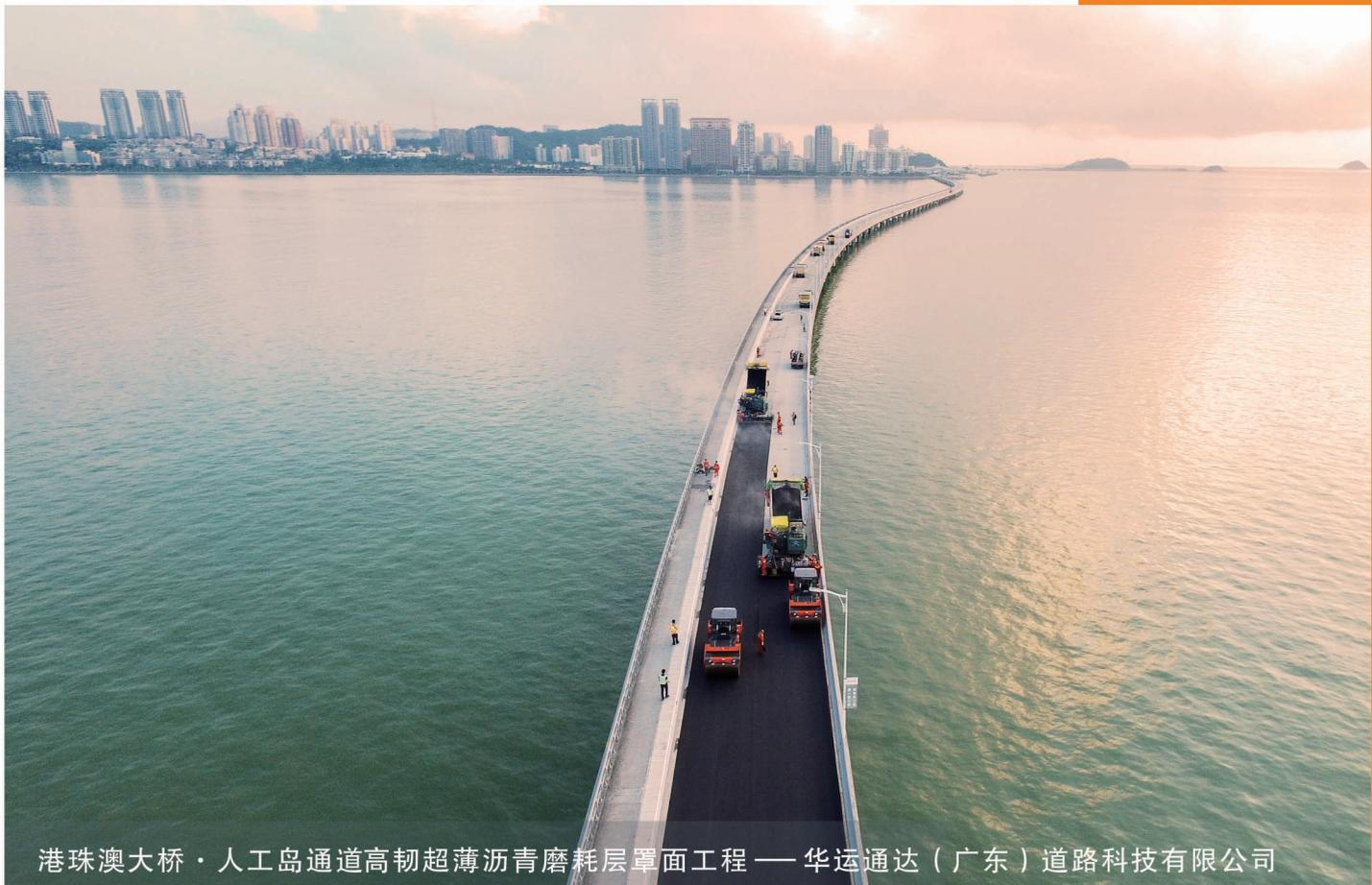
港珠澳大桥·人工岛通道高韧超薄沥青磨耗层罩面工程——华运通达（广东）道路科技有限公司
