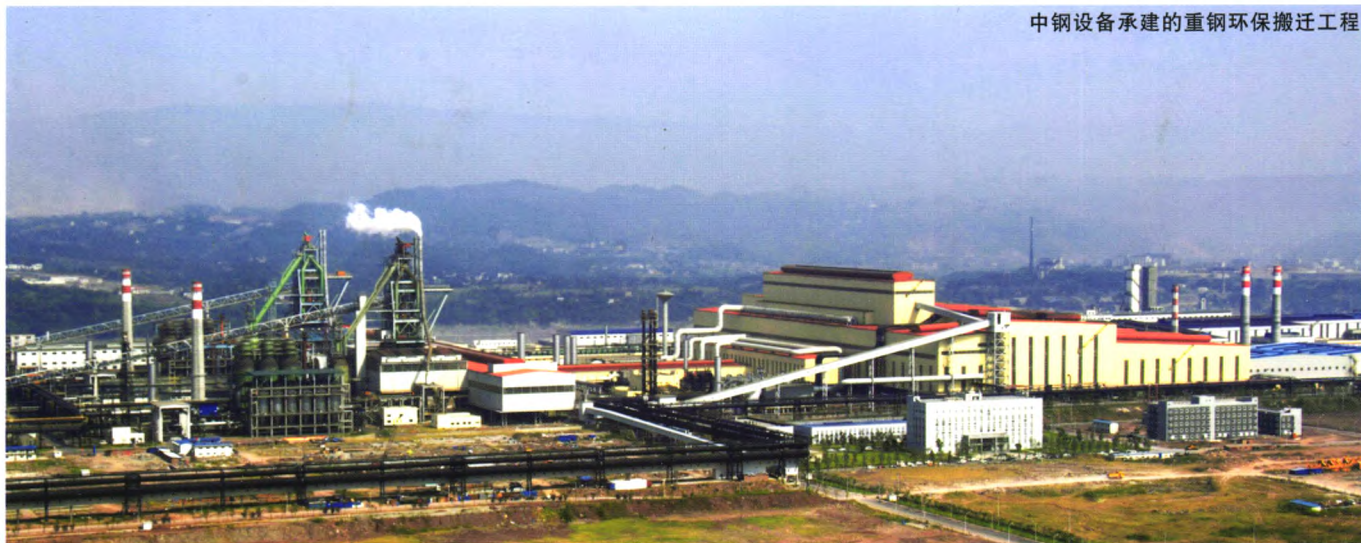
中钢设备承建的重钢环保搬迁工程
