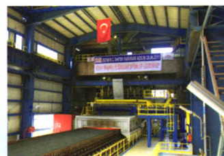
中钢设备承建的土耳其ISDEMIR 300平米烧结
