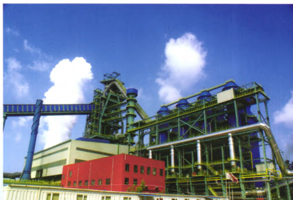
中钢设备承建的土耳其ISDEMIR3050立米高炉
