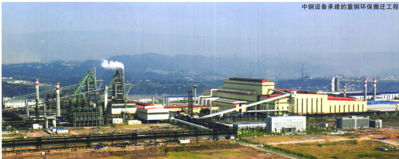
中钢设备承建的重钢环保搬迁工程
